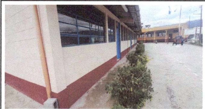
Foto 5: Sustitucion Canal y Bajada de agua pluvial.
