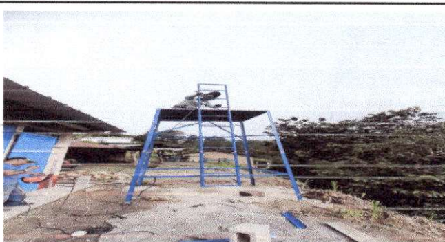
Foto 4: Reparación y mantenimiento de sistema (depósito de agua)
