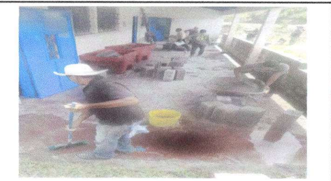
Foto 4: Inicio de Muro Perimetral
