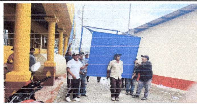
Foto 3: Reparación y mantenimiento de sistema (depósito de agua)
