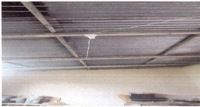
Foto 1: Reparación de Sistema Eléctrico
