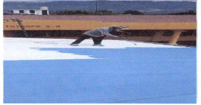
Foto 2: Pintado de techo
